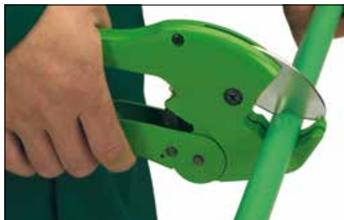
Avklippning av röret
