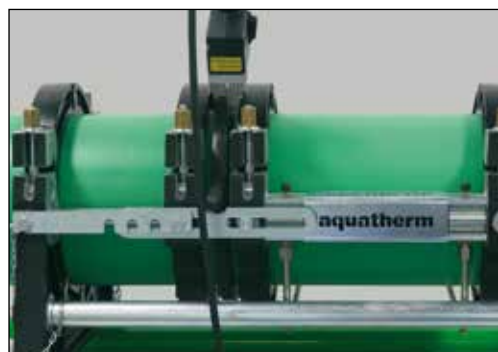
Rören trycks mot svetsvärdet
