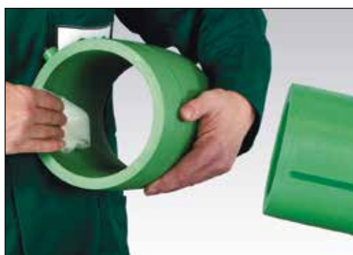
Rengör svetsmuffens insida
